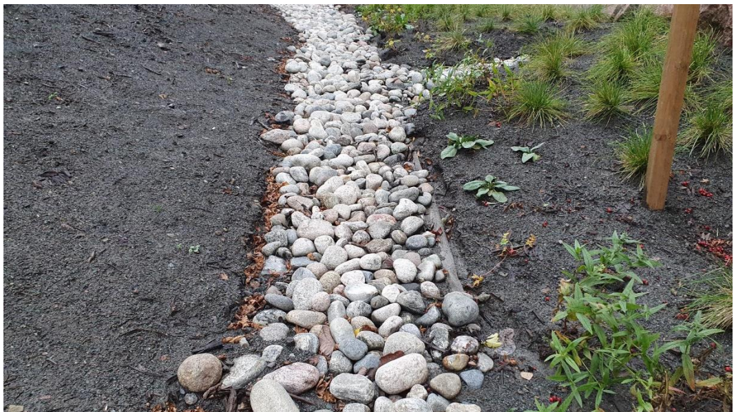
Bilde 3: Viser duk liggende under topplaget med elvesingel som et skille mellom vekstjorda og elvestein.
