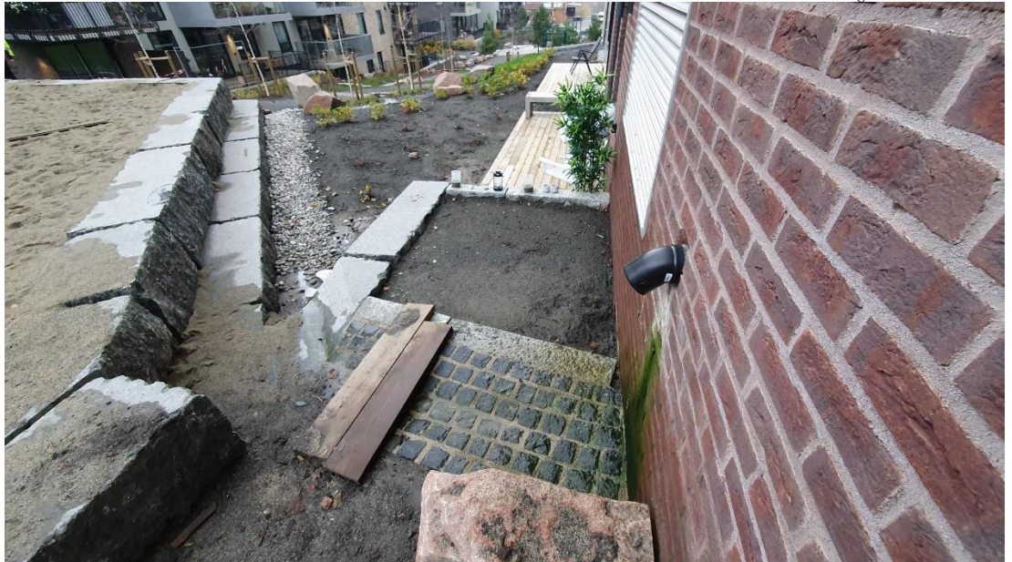
Bilde 8.: Takvann ført via taknedløp i en støpt renne av smågatestein for deretter å skulle renne videre via elvesteinsfeltet lagt i en organisk form, gjennom en betong klopp og inn i overvannsløsningen.
