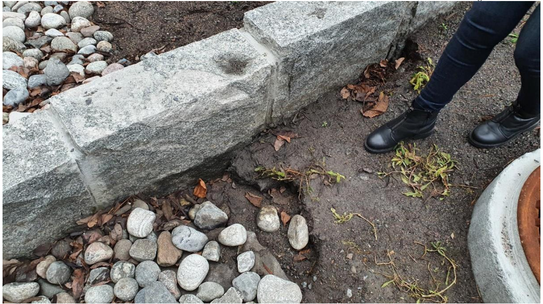
Bilde 6: Vannet har undergravd granitt terskelen.
