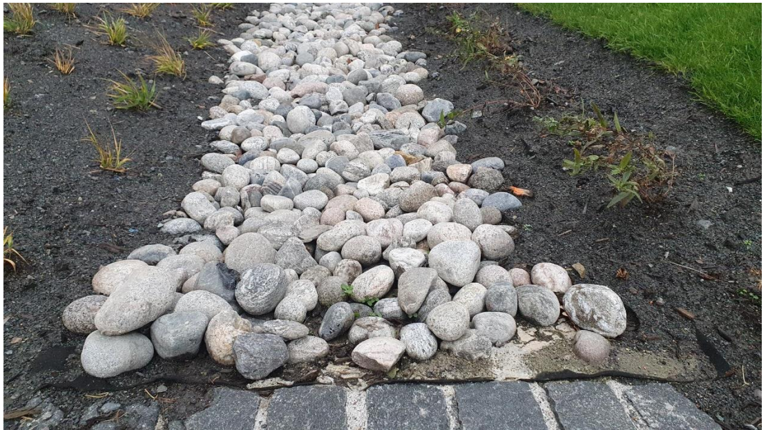
Bilde 3: Viser duk liggende under topplaget med elvesingel som et skille mellom vekstjorda og elvestein.
