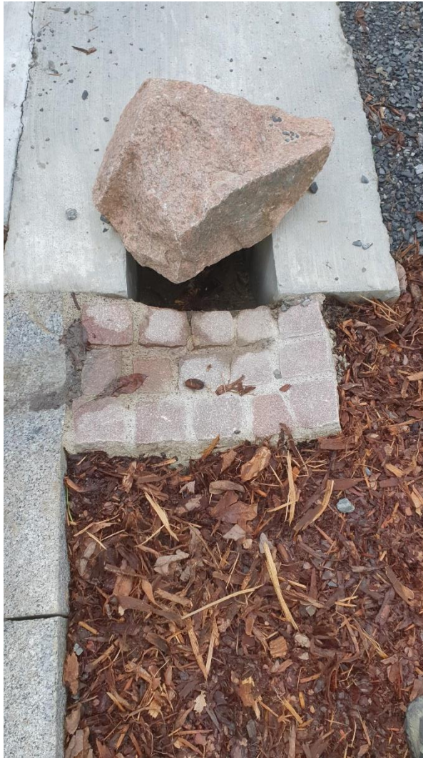
Bilde 12: Betong klopp med åpning, og vannet har ført med seg blader, bark og omkringliggende masser inn i kloppen.
