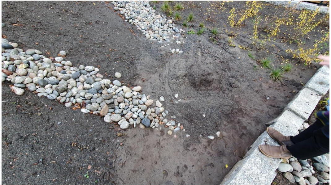
Bilde 16: Oppsamling av eroderte masser nederst i skråningen.
