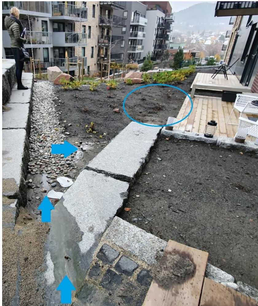
Bilde 11: Takvannet rant ikke i elvesteinsfeltet og til overvannsløsningen slik som tenkt, men fulgte de blå pilene og samlet seg foran treplatting til beboer.
