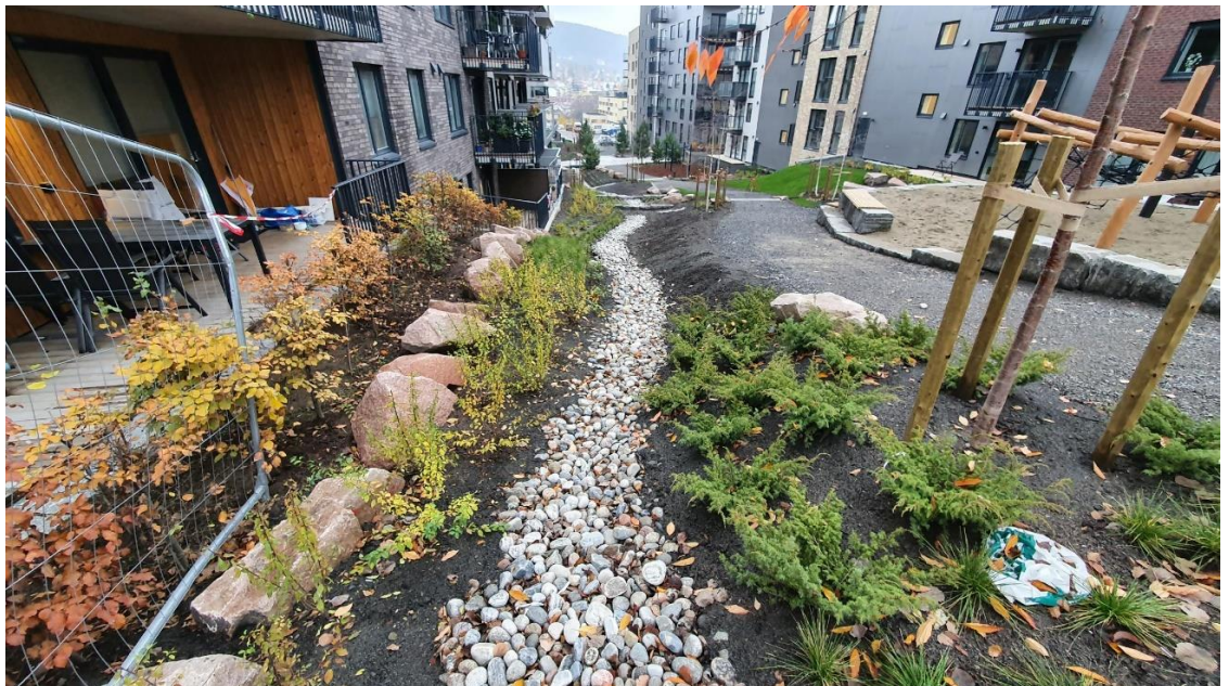
Bilde 2: Elvestein lagt som topplag gjennom hele overvannsløsningen.
