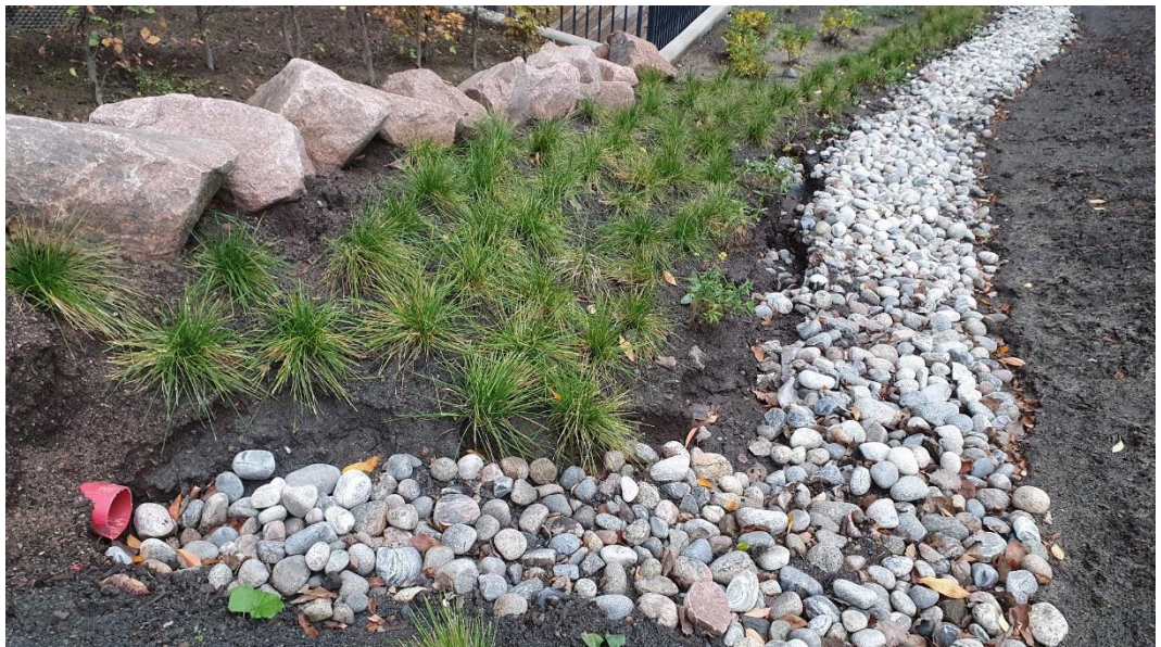
Bilde 6: Vannet har undergravd granitt terskelen.
