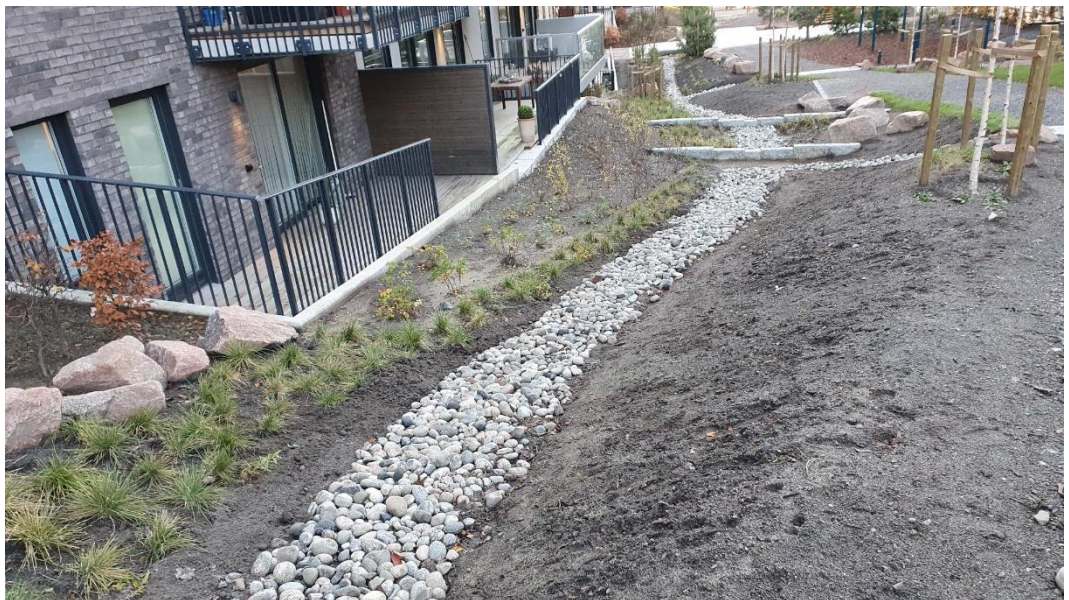
Bilde 22 og 23: Vekstjord lagt på de eroderte områdene i forkant av befaringen.
