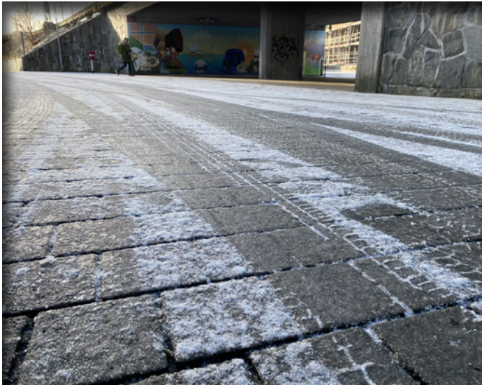
Uten finstoff i oppbyggingen og fugene er de permeable dekkene mer robuste mot tele, og tryggere perioder med tining og frost.
